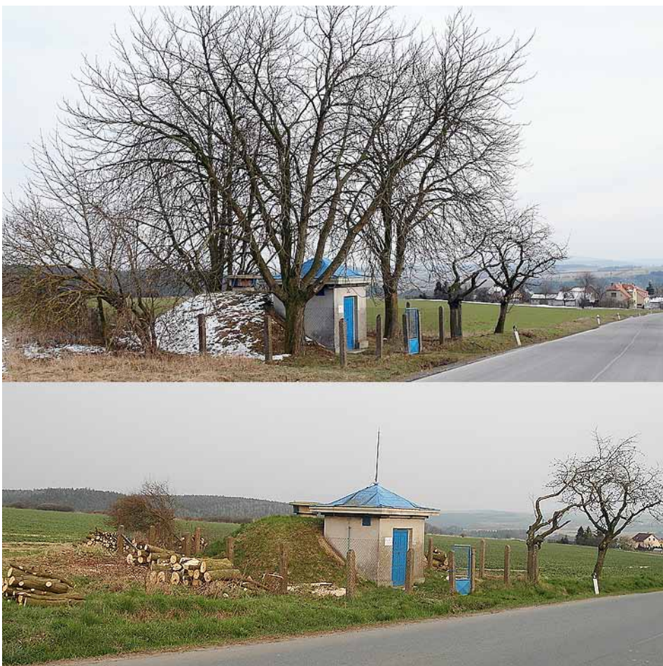
U horního vodojemu, nad obcí Kozojedy, firma VAK nechala odstranit náletové dřeviny a pokácet několik vzrostlých kaštanů. Důvodem bylo prorůstání kořenů do stavby a možné poškození bazénu na pitnou vodu pro naši obec. Josef Lomička - starosta obce
